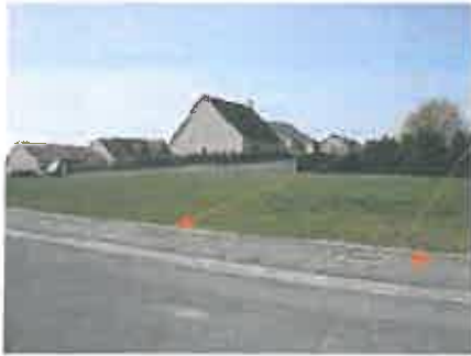
Chambre de desserte locale (boisement) dédiée à France Télécom
